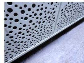
Este panel se utiliza en trasdosados y como panel absorbente para falsos techos a fin de disminuir la reverberación de un recinto o bien para atenuar, por absorción, el ruido existente en una sala. En el caso de los trasdosados, siempre se coloca sobre una superficie existente y es muy útil en interiores de salas de máquinas construidas en obra civil. Su principal función es la absorción acústica.
