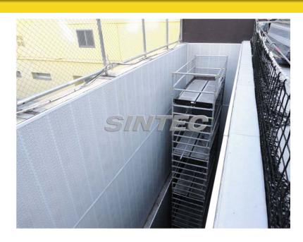
El montaje se realiza mediante perfiles en U y en Z de chapa de acero. Su colocación es muy sencilla y permite cámaras de aire detrás del panel, con distinta separación con objeto de atenuar el ancho de banda requerido.
