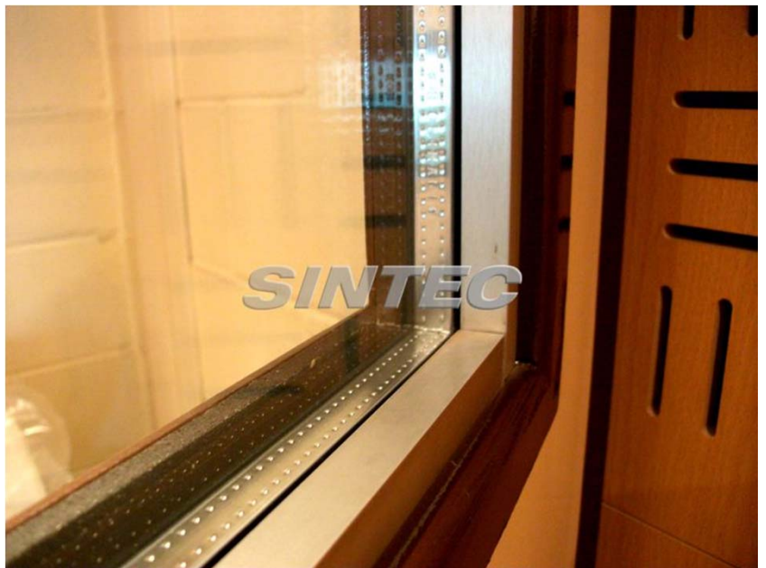
Las juntas de neopreno y los perfiles de cierre ofrecen la estanqueidad necesaria para poder ofrecer los niveles de aislamiento deseados.
